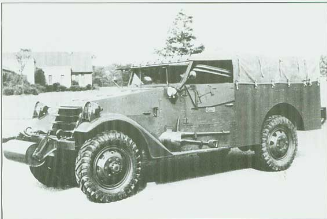
M3A1 Scout Car z plandeką. Na drzwiach pojazdu widoczna plakietka z oznaczeniem kawalerii armii USA. A M3A1 Scout Car fitted with tarpaulin. On the door is a metal plate with U.S. Army cavalry badge. [Tank Museum 3073/D3]
