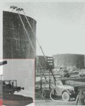
Collapsible foam elevator on ГАЗ-63 all-wheel drive chassis at oil reservoir training smothering Teleskop-Schaumlörderanlage auf Fahrgestell GAZ-63 bei der Übungslöscharbeit am Erdölbehälter Телескопический пеноподъемник на шасси ГАЗ-63 в учебном тушении нефтяного резервуара
